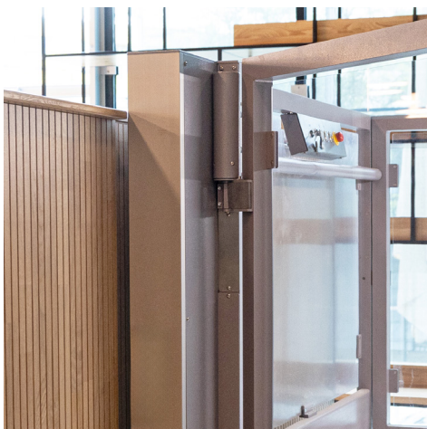
Apertura automática de puertas
